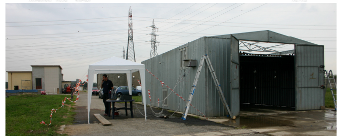
Figura 4 - Locale impiegato per i test relativi alle erogazioni indirette.
