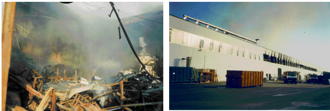
Incendio Panini (Adespan) Bomporto : come classificare una mancata apertura di un preaction sprinkler perchè un'interfaccia non opera correttamente pochi giorni dopo il test di accettazione dell'impianto ?
